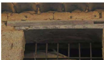
Via Pilar, 13. Muratura. Mattoni: 20x8xnr cm
