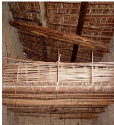
Fig. 24 - Villamassargia, via Mercato, 11. Interno del granaio, soppalco in legno e incannucciato.
